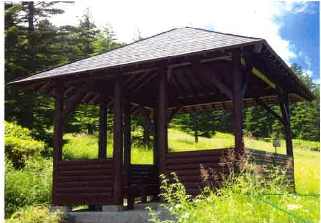
長野県麦草峠中部森林管理所 四阿 (施工後) (ウッディセラ)
