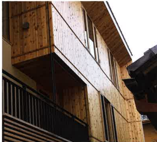
東京都新宿区市ヶ谷加賀個人宅CLT外壁 (ヒノキ)
