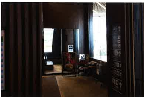
JR東日本小淵沢駅舎 内装制限部分塗装(不燃木材白華防止)
