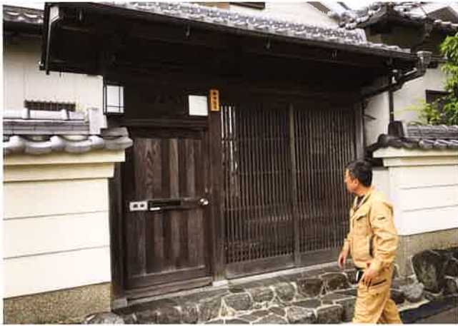
富山県富山市個人宅門 (施工前)
