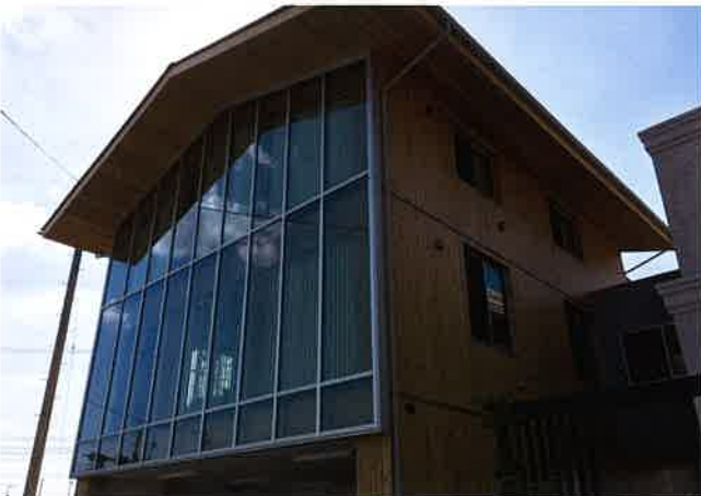
福島県郡山市藤田建設工業郡山営業所 (スギ)
