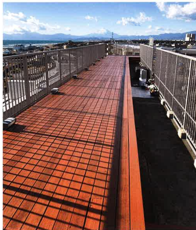
マンション屋上デッキ 施工前(左)、施工後(右)(木あじ、テリオスウッド、滑り止め塗装)
