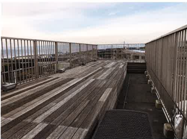
マンション屋上デッキ 施工前(左)、施工後(右)(木あじ、テリオスウッド、滑り止め塗装)
