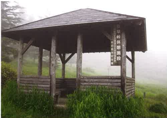
長野県麦草峠中部森林管理所 四阿 (施工前)
